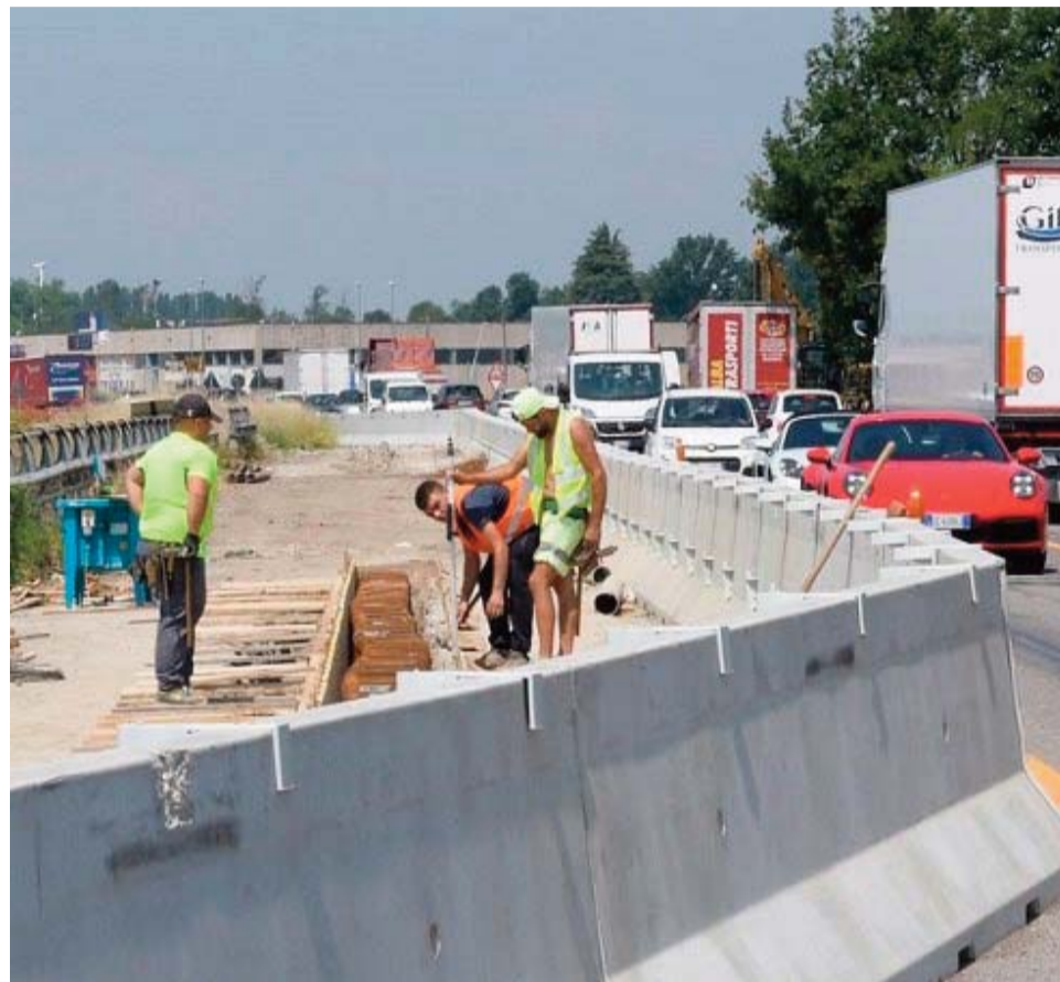
uno dei cantieri della tratta di Paullese interessata dai lavori
