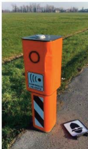
Le tre colonnine vandalizzate
