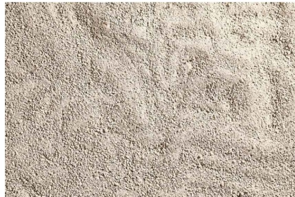
Pista ciclopedonale in calcestre. Tonalità Bianca, ottenuta da una miscela di puro sasso bianco. Granulometria 0/50 mm. Strato di Calcestre di 15 cm applicato su una base in stabilizzato. L'insieme degli strati riesce a formare per compattazione una crosta particolarmente resistente e stabilizzante. L'aspetto finale è quello di un sentiero realizzato con ghiaia fine.
