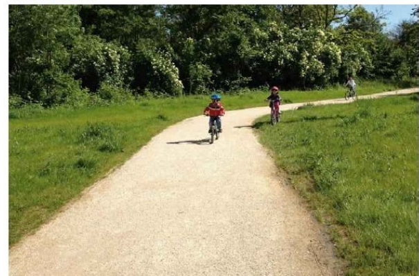
Pista ciclopedonale in calcestre. Tonalità Bianca, ottenuta da una miscela di puro sasso bianco. Granulometria 0/50 mm. Strato di Calcestre di 15 cm applicato su una base in stabilizzato. L'insieme degli strati riesce a formare per compattazione una crosta particolarmente resistente e stabilizzante. L'aspetto finale è quello di un sentiero realizzato con ghiaia fine.
